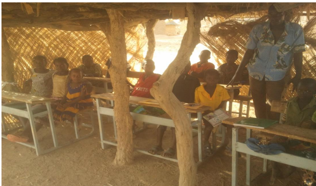
Photo n°1 : centre à passerelle du village de Nakambtenga construit en secco par la communauté villageoise.
